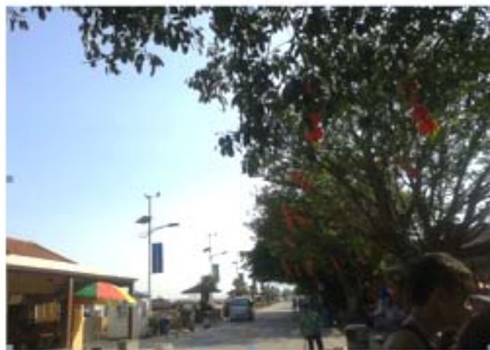
(可見街道一旁都是同類型的風能路燈“頭”裝風扇,“腰”掛太陽能電池板,相隔七八米。)
